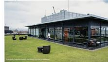
El edificio cuenta con una cubierta exterior verde construida en el piso 12 de 555 m<sup>2</sup>, que emplea gramíneas sobre un sistema de drenaje, el cual permite mantener la suficiente cantidad de agua para alimentar el césped y para evacuar la sobrante. Este espacio, diseñado para el uso y disfrute de quienes allí laboran, permite recoger aguas lluvias para luego enviarlas al tanque de almacenamiento que provee al espejo de agua y al sistema de riego.
